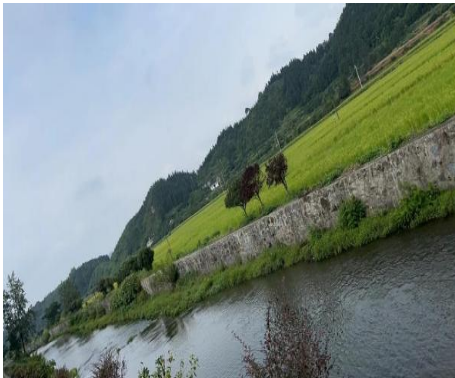
图 2.4 堡子镇右岸已建挡墙
