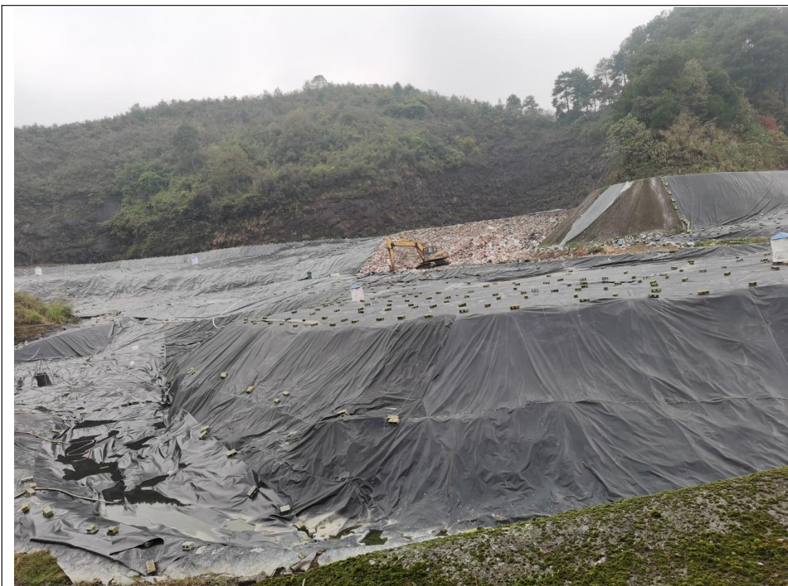
图 4-3 作业面裸露情况
